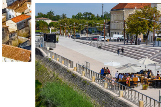
Aménagement des quais en espace de promenade, capitainerie, pontons...
